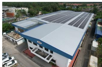
ソーラーパネル (マレーシア現地法人)
