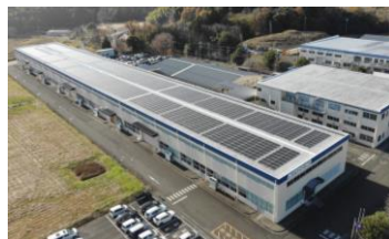
ソーラーパネル (綾部 産機工場) →グリーンエネルギー 100%を達成
