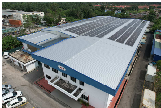
マレーシア現地法人に ソーラーパネル設置 (2022年9月稼働)
